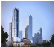
建筑远距离位移检测
