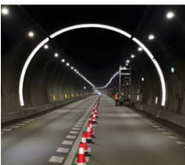
隧道位移测量
