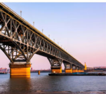
大型桥梁位移测量
